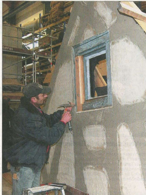
Der Holzbock hat seine Spuren hinterlassen in den vergangenen 250 Jahren. Teilweise müssen Balken ausgetauscht werden. Fotos: Tanja Knieler
